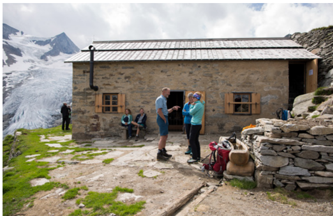
Alte Prager Hütte nach dem Rückbau 2019 mit der ursprünglichen Dachhöhe von 1877 und erneut zweireihig eingedeckten Dachschildeln aus Lärchenholz sowie nach historischem Vorbild erneuerten Fenstern und Fensterläden
